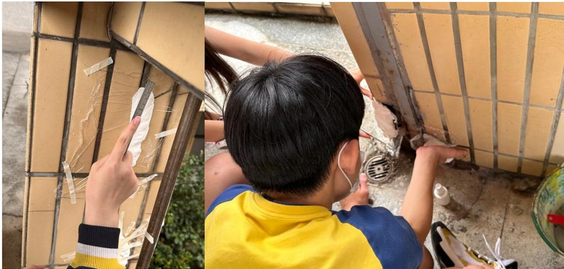
B 學生操作流程：設計團隊前往天橋，鎖定具體的破損角落。用輕質土按壓在破損處，待乾之後小心地取下，完成修補處的「模型」，同時測量尺寸並拍照記錄周遭環境。
